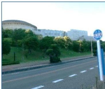
① 国道夢舞台バス停(降車場所) Kokudo Awaji Yumebutai bus stop (Drop-off area)
